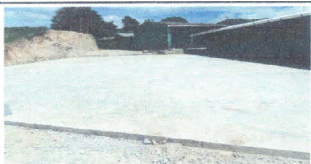
Foto 5: Fianlizacion de repacion de piso torta de cemento ya realizado.
