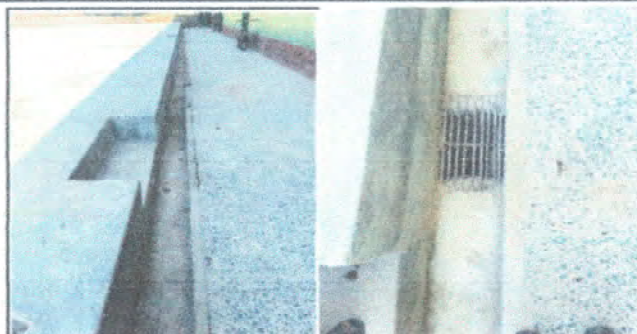
Foto 2: Finalizacion de cunetas de concreto ya instalados para desagüe enfrente de la escuela.
